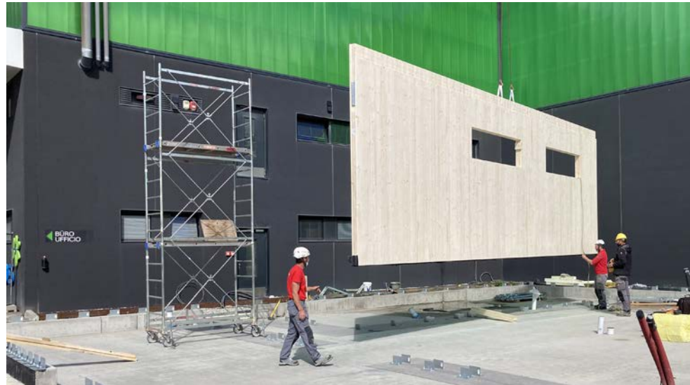
Montage vorgefertigte Brettsperrholzwände
