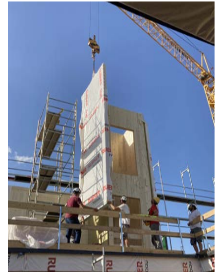
Montage Aufzugsschacht aus BSP
