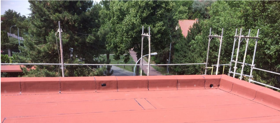
Dachabdichtung als Einzelwasserbecken
